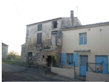
Habitat vacant dans un centre-bourg
