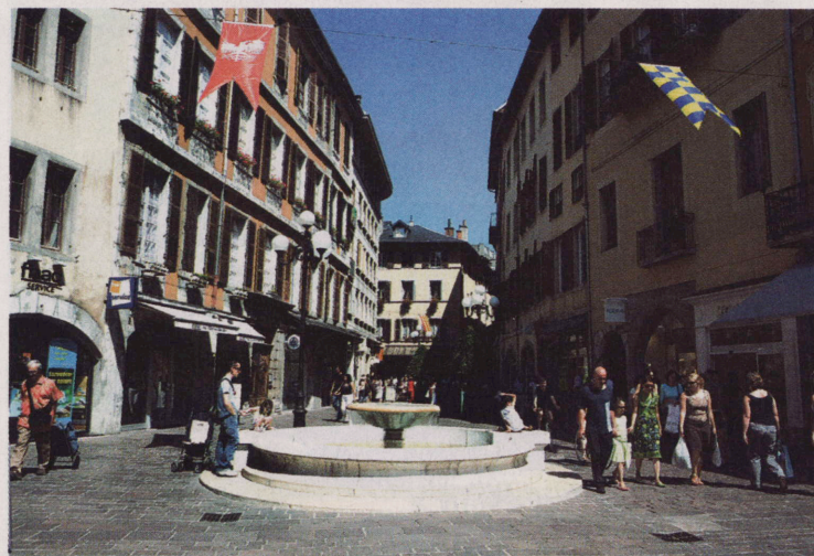
Quelque 500 immeubles du centre ancien ont fait l'objet d'un diagnostic sécurité. Parmi eux, une centaine est considérée comme prioritaire.
