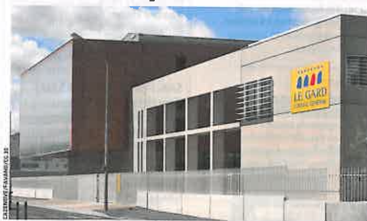
Du fait de malfaçons, le nouveau bâtiment ouvrira avec deux ans et demi de retard.
